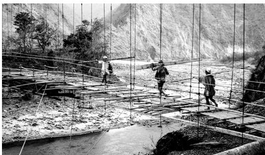
नदीमा भोलुङ्गे पुल निर्माण हुँदै
