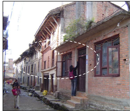
Fig 9 (d) Change in floor height in old & new constructions
