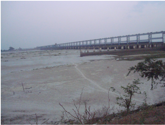
Dry Kosi Barrage
